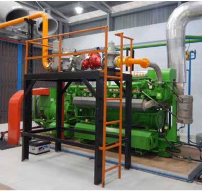
Biogasmotor in Mukomuko
