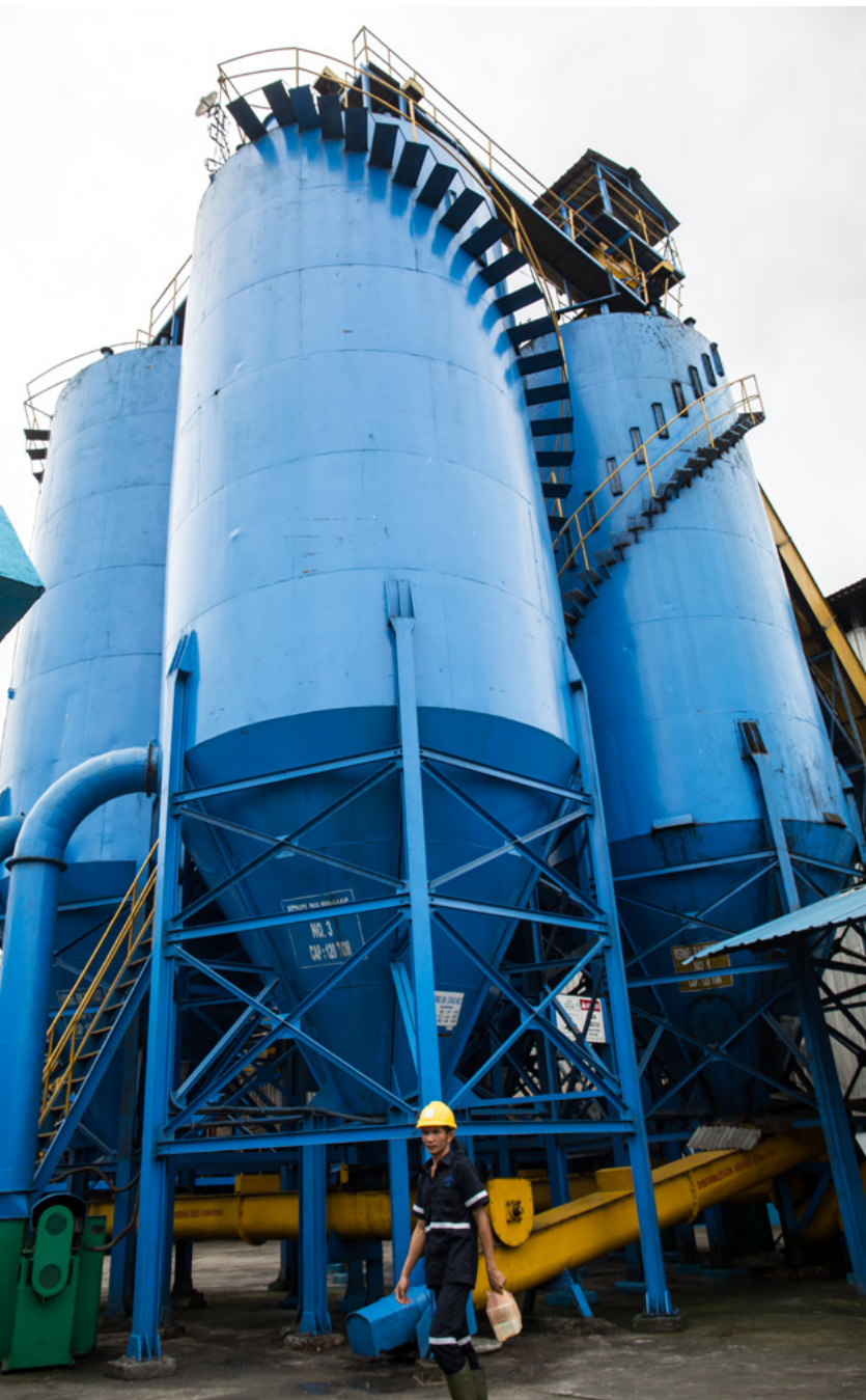
Silo's voor bulkopslag van palmpitten
