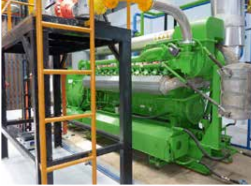
/// Close-up van een gasmotor ///
