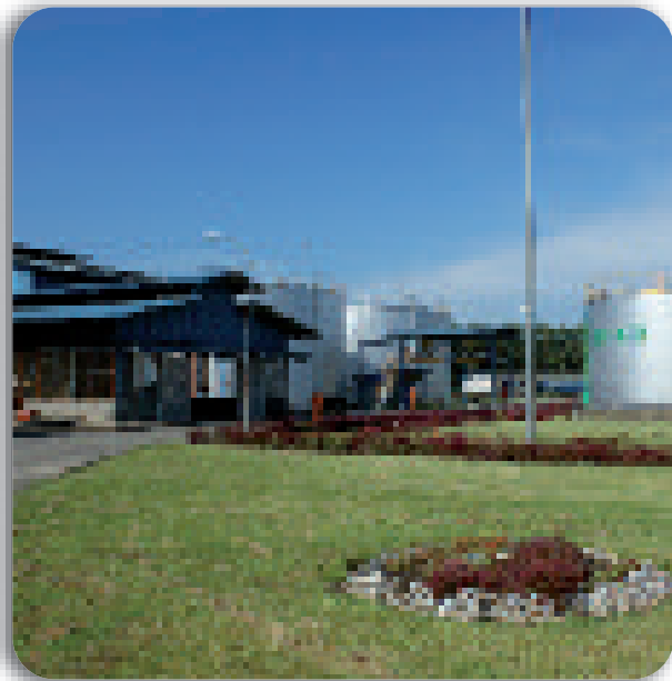
Tanks à l'usine de Navo (PNG)
