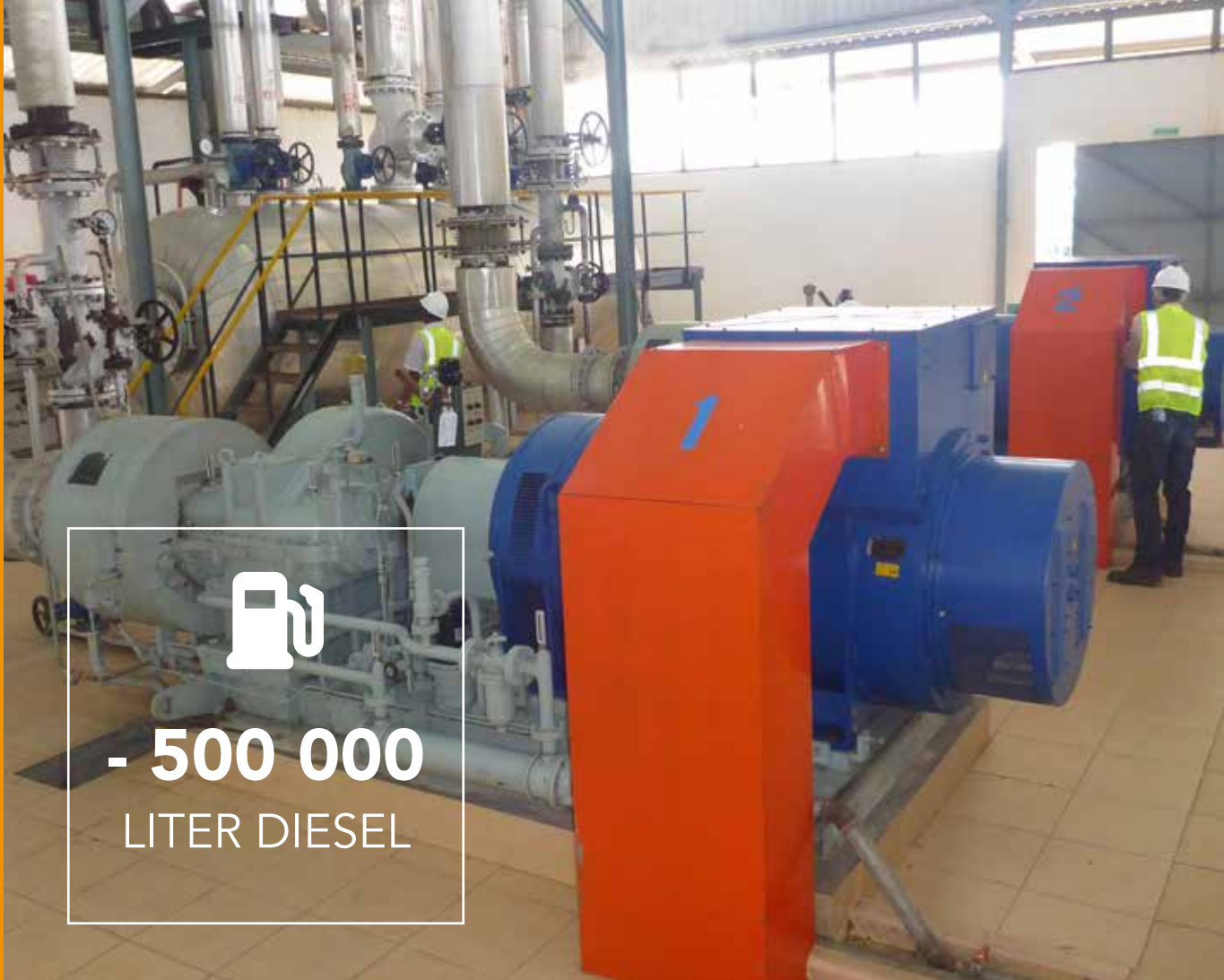
Twee stoomturbines op de voorgrond en het stoomexpansievat op de achtergrond
